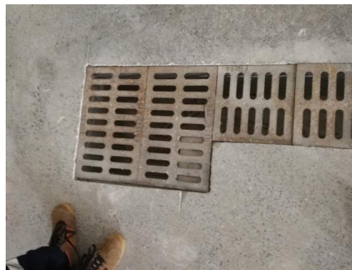
危废暂存间收容池
