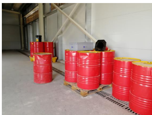
危废暂存间边沟
